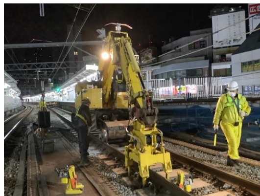
写真 2 四頭タイタンパによるつき固め
