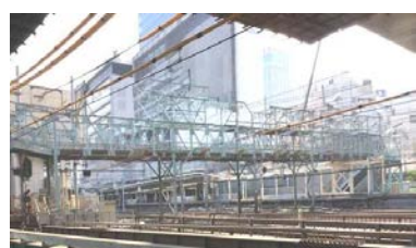
写真-1 こ線橋全景
