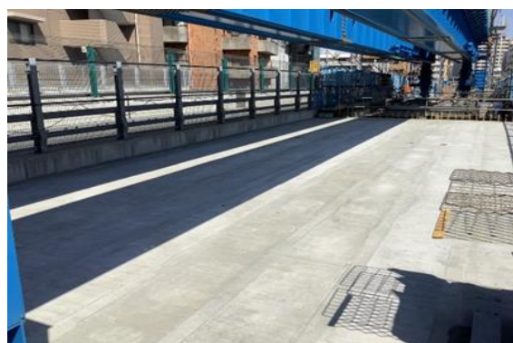
写真1 間詰め部コンクリート打設完了
