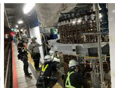
写真-3 櫓を使用した建込の様子
