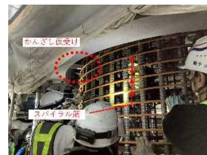
写真-4 鉄筋籠仮受け状況
