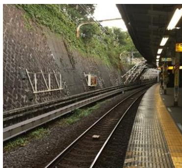
図 2. 現地状況（1期施工）
