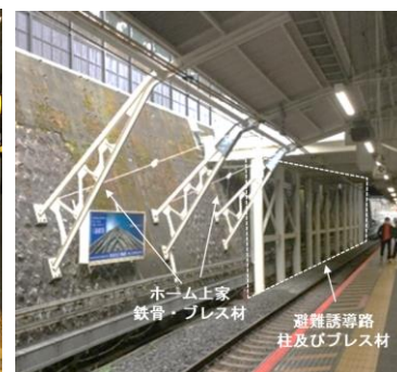
図 3. 現地状況（2期施工）
