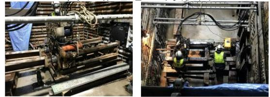
写真-1,2 誘導管施工
