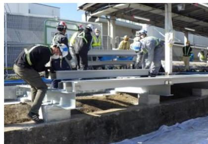
写真-1 FRP床版設置作業
