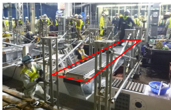
写真-1 ローラーコンベア設置
