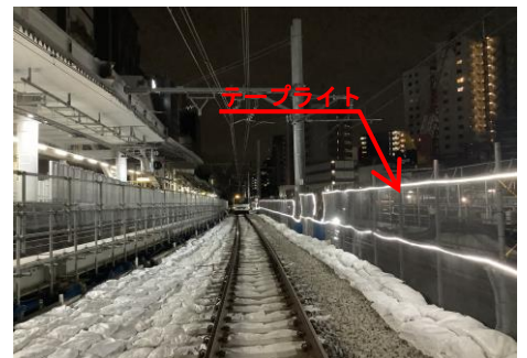
写真 4. 線路防護網の設置状況
