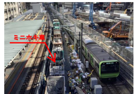
写真2. ミニホキ車によるバラスト散布
