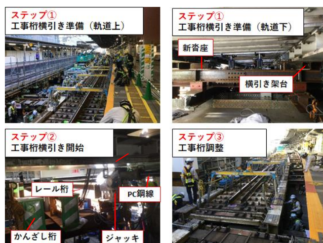
図-2 工事桁横移動施工手順
