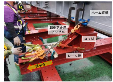
図-5 試験施工状況
