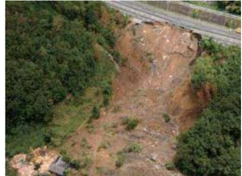
写真-1 盛土崩壊の様子 1)
