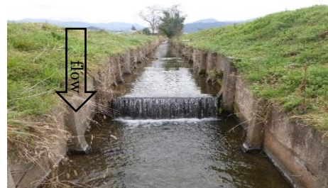
写真-1 水路における落差の例
