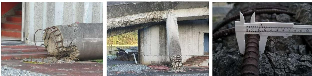
写真1 1番目の廊下橋脚の転倒 写真2 3番目の廊下橋脚の転倒 写真3 橋脚の鉄筋直径測量
