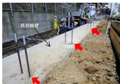
図 3. 既設擁壁に先行設置されたアンカー(赤矢印)
