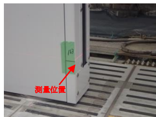
写真3 ホーム測量写真
