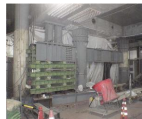
写真 1 仮橋脚現地写真
