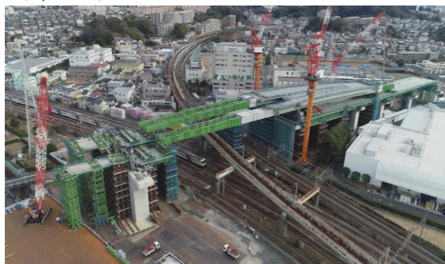
写真-2 第1回送出し完了
