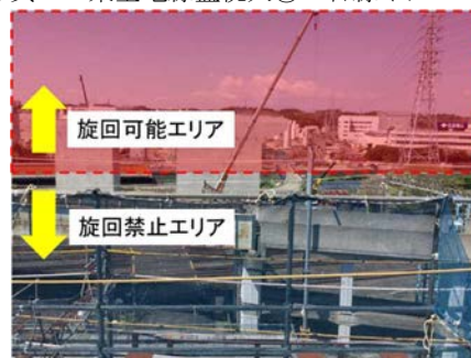
写真-2 架空電線監視人① 目線イメージ
