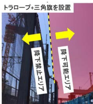
写真-3 架空電線監視人② 目線イメージ
