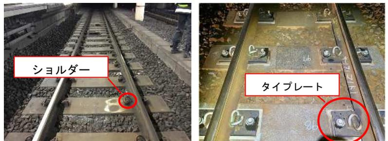
図-3 座面式マクラギ(左)とタイプレート式締結装置(右)
