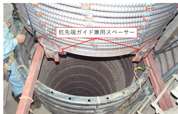
写真-4 杭先端ガイド兼用スペーサー
