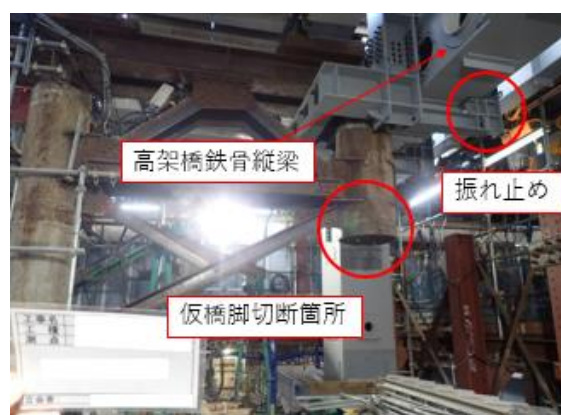
図-6 仮橋脚受替え後
