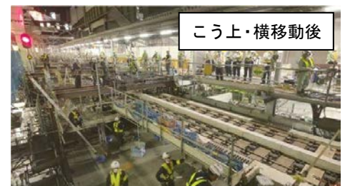
図-6 工事桁こう上・横移動
