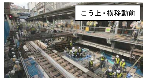
図-5 工事桁の位置調整
