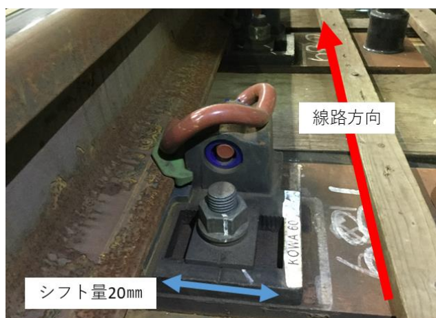
図4 曲線半径を考慮した締結装置
