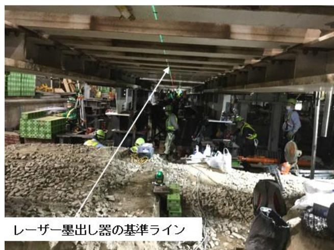
図5 レーザー墨出し器による基準ライン照射
