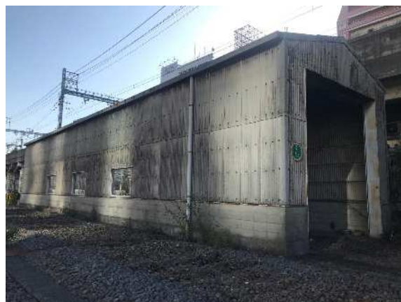
写真-2 旧検修庫の様子
