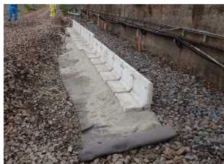
写真-1 透水性スラグモルタル・L型擁壁試験施工
