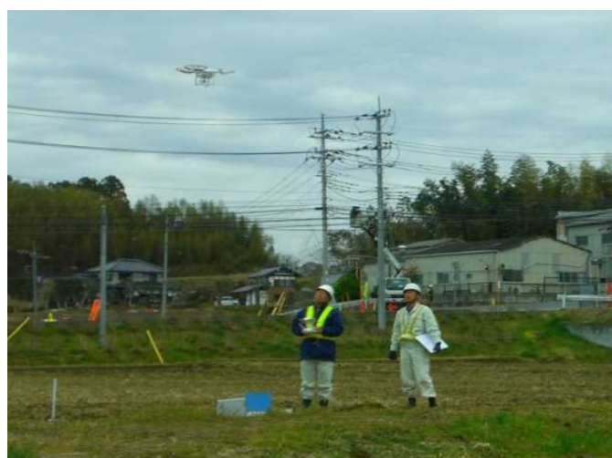
図.1 UAV による空中写真測量（3次元起工測量）
