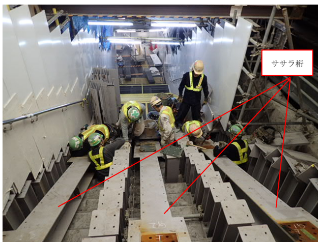
写真-2 仮階段ステップ設置状況
