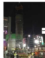
図 - 6 クローラクレーンによる建込
