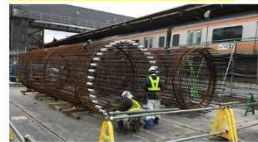
クローラクレーンによる建込
