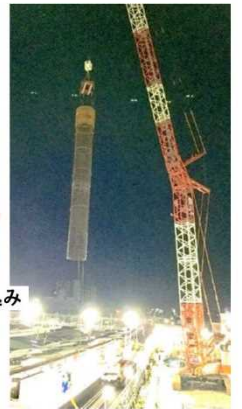
図 - 6 クローラクレーンによる建込
