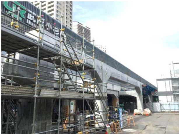
写真－1 コンクリート打設完了
