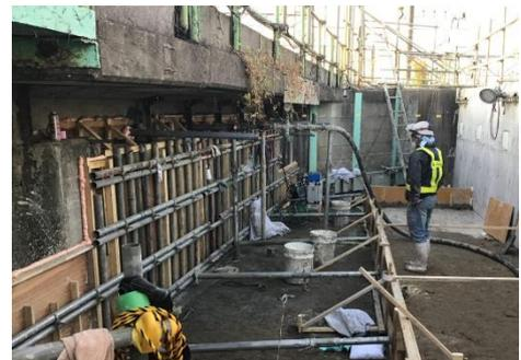
図5 型枠の写真（南入出線側）
