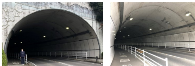
図-3 アンケートで用いたトンネルの写真
