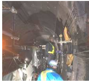
写真-③ 漏水の多い区間の状況と裏込め注入工施工状況
