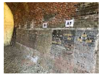
写真-② 塗布材試験施工
