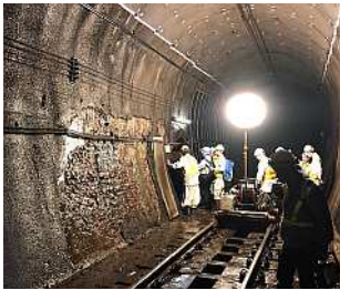
写真-③ 漏水の多い区間の状況と裏込め注入工施工状況
