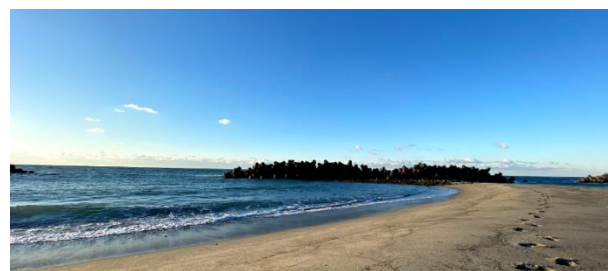
図 4 浜松市沿岸のテトラポット
