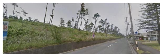
図 5 浜松市沿岸の堤防の状況
