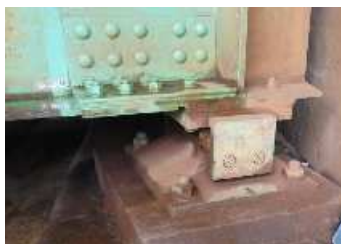
図-12 支承交換前
