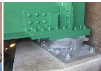
図-13 支承交換後
