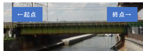
図-1 橋りょう全景
