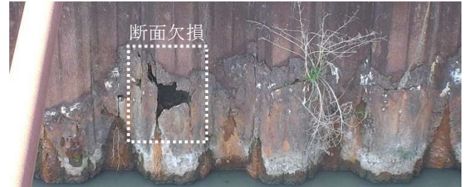
図1 既設鋼矢板における断面欠損の例
