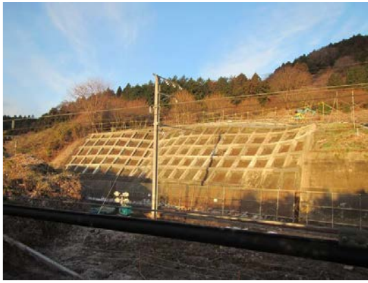
写真3 土留壁崩壊現場の復旧工事（のり面工）
