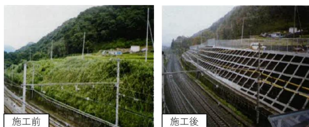
写真1 降雨防災強化対策の一例（のり面工）
