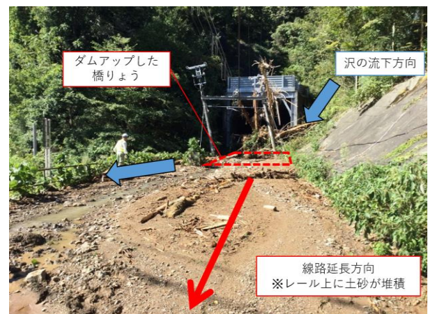
写真4 災害発生翌日の様子（線路内土砂流入）
