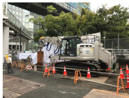
写真-2 鋼管杭打機
