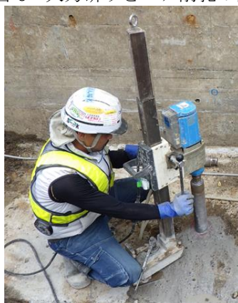
写真-1 コア削孔機
