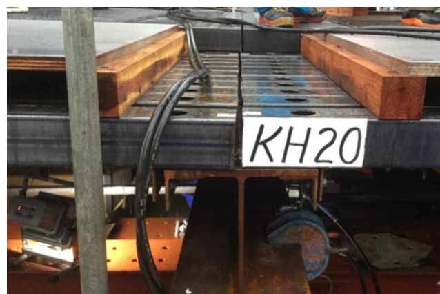
図-8 試験施工による遊間の確保
