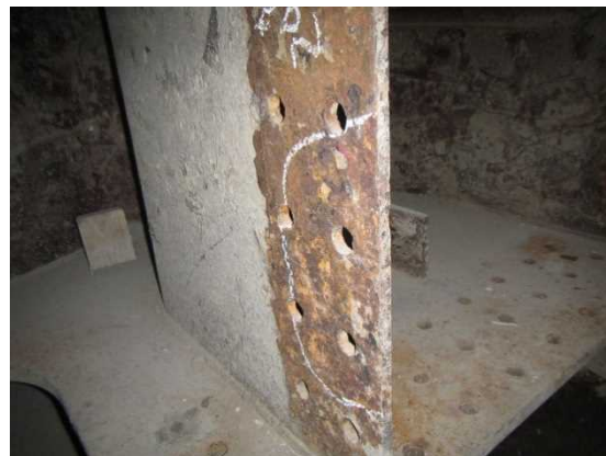
写真-1 既設側仕口側表面状態
