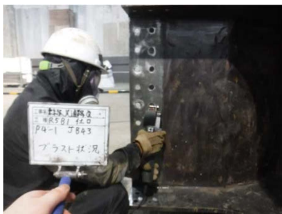
写真-2 仕口ケレン状況
