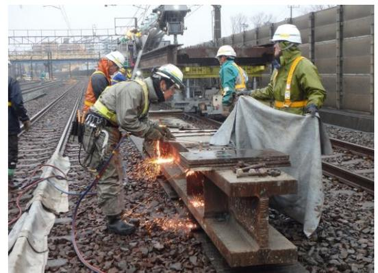
写真-2 かんざし桁の切断作業中
