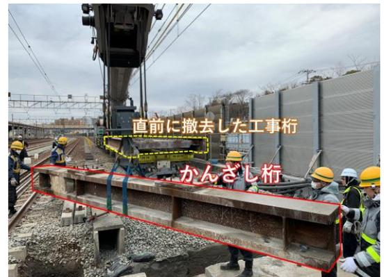
写真-1 鉄クレによるかんざし桁撤去
