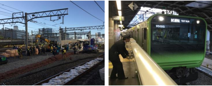
図-4 切換口A 施工中(左)、試運転列車(右)
