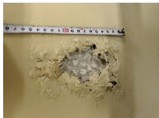
写真-1 ポリウレア樹脂2mmが断裂し、コンクリートが削剥した様子
