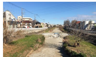
写真-1 瀬切れの状況 (2020/1/2 秋津南橋 下流側)
