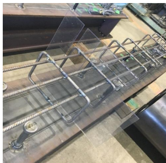
写真 1 コンクリート打設前の試験体目地部
