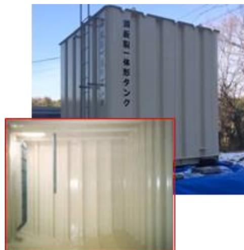
写真-1 鋼板製タンク
