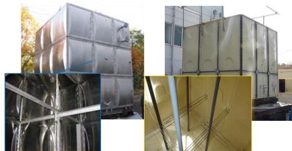
写真-2 SUS 製タンク 写真-3 FRP 製タンク
