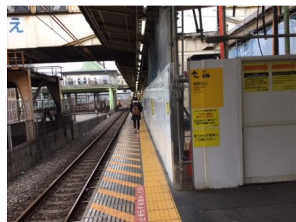
図-1 ホーム上の仮囲いの一例
