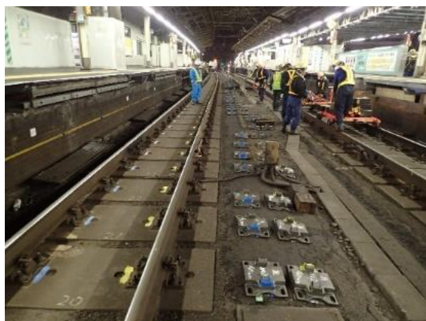
写真1. タイプレートと枕木の印付け
