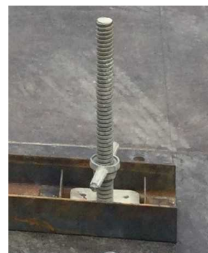
写真-1 ジャッキベース設置部
