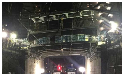
写真-3 桁撤去状況図
