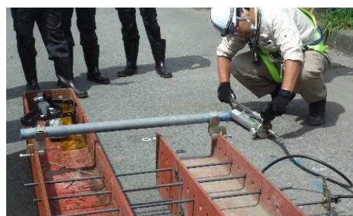
写真-2 センターホールジャッキを用いた試験施工
