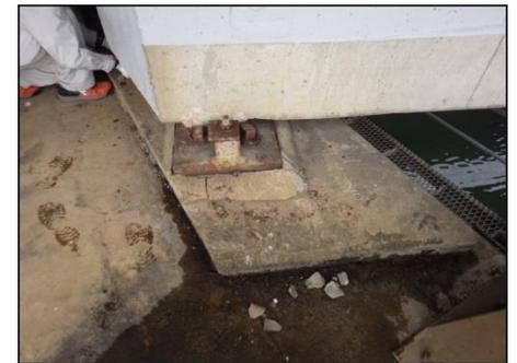
写真-2 変状発生箇所の支承部全景
