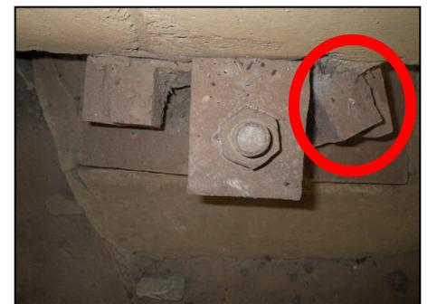
写真-3 変状発生箇所の支承部近景
